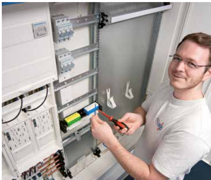
An den Montagewänden des EBIC können die Nachwuchskräfte üben und sich gezielt auf Prüfungen vorbereiten.
